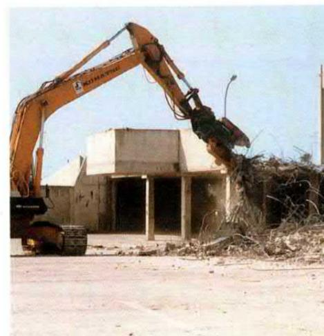
Maschineller Abbruch mit Betonzange und Einschlagen mit Abbruchbirne nach Abschluß der Demontagephase
