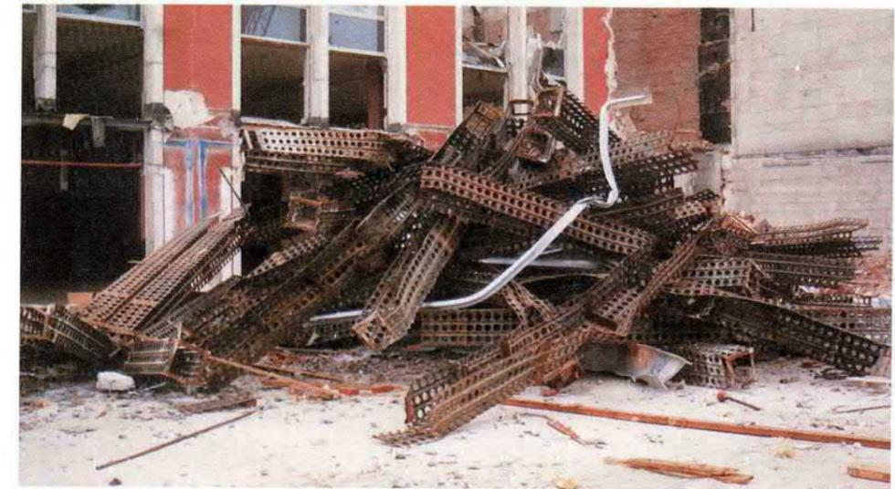
Separierte Stahlteile aus Zwischendecke
