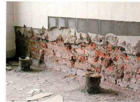
masse am Beton befestigt ist. Nach Abspitzten der Plattenbeläge wurde die Dachpappe händisch ausgebaut und die Dichtungsmasse abgespitzt. Dichtungsmasse und Dachpappe wurden im HKW entsorgt.
