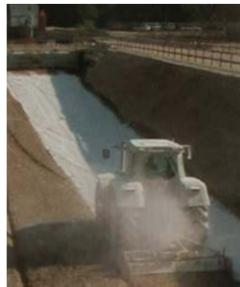
**Bodenverbesserung.** Wird wieder verwendbarer Boden beim Zwischenlagern zu feucht, muss er trotzdem nicht entsorgt werden. Er lässt sich auch dann noch in Straßendämme einbauen, wenn man ihn dabei mit Kalk verfestigt.
