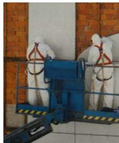
**Gehört fast immer dazu: Sorgfältige Schadstoffsanierung.** Gesundheitsgefährdende Materialien, wie zum Beispiel Asbest, findet man in nahezu allen etwas älteren Gebäuden. Sie müssen vor dem Entkernen fachgerecht ausgebaut werden.
