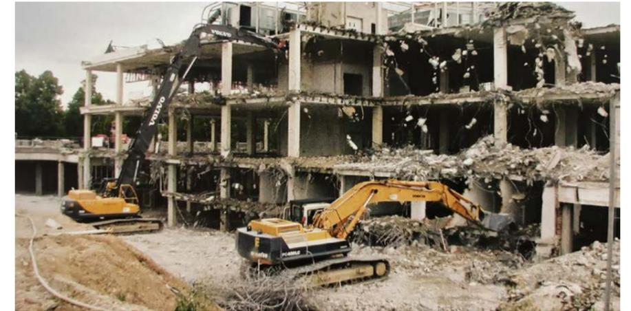
**Maschineller Abbruch.** Der entkernte "Rohbau" wird mit hydraulischen Zangen und Meißeln zerkleinert. Dabei wird der Stahlbeton vom übrigen Schutt getrennt.
