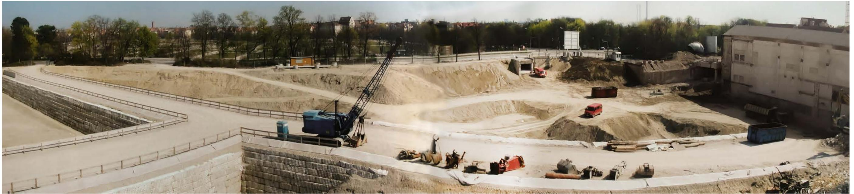
**Straßendämme.** Weil die neuen Straßen zum Teil da verlaufen, wo früher Tiefgeschosse waren, musste dort der Unterbau bis zu 9 m aufgeschüttet werden. Das ging nur mit steilen Böschungen, die auch zugleich als Baugrubensicherung dienen konnten. Und das erforderte eine Bewehrung mit zugfestem Geogewebe.
